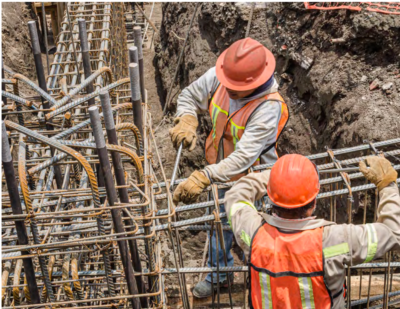
Trabajadores de la construcción que ponen los cimientos con barras de hierro/mofles/istockphoto.
